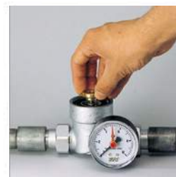
3. Навинтите регулировочное кольцо на стержень мембраны, который специально для этого снабжен резьбой.
