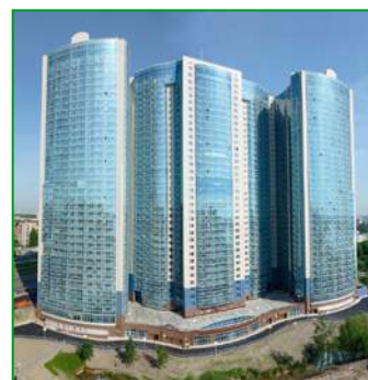
Санкт-Петербург ЖК «Невский»
